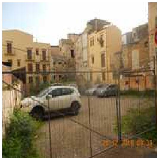
Vista generale dell'area
